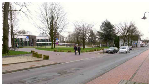
Frankfurter Straße vor dem Umbau
